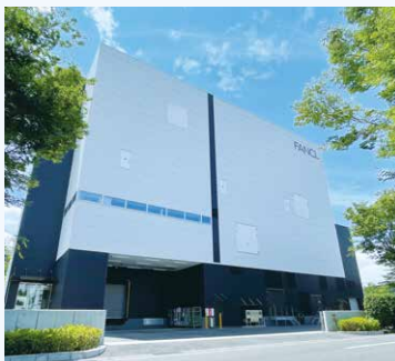
「マイルドクレンジング オイル」の新工場
