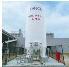
滋賀工場のLNGタンク(2022年7月よりカーボンニュートラルなLNGを補充開始)
